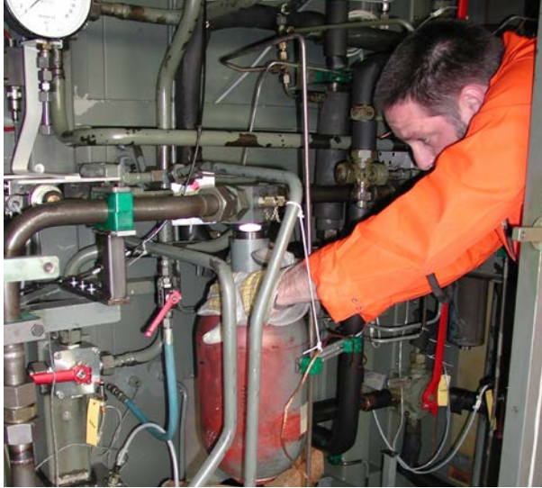
Abb. 1 Instandhalter bei Wartungsarbeiten
