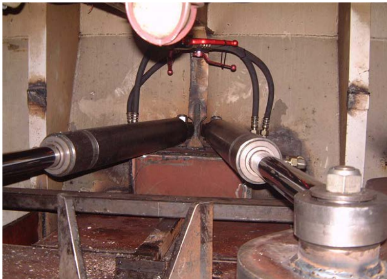
Abb. 42 Quetschgefahren an einer Ruderanlage
